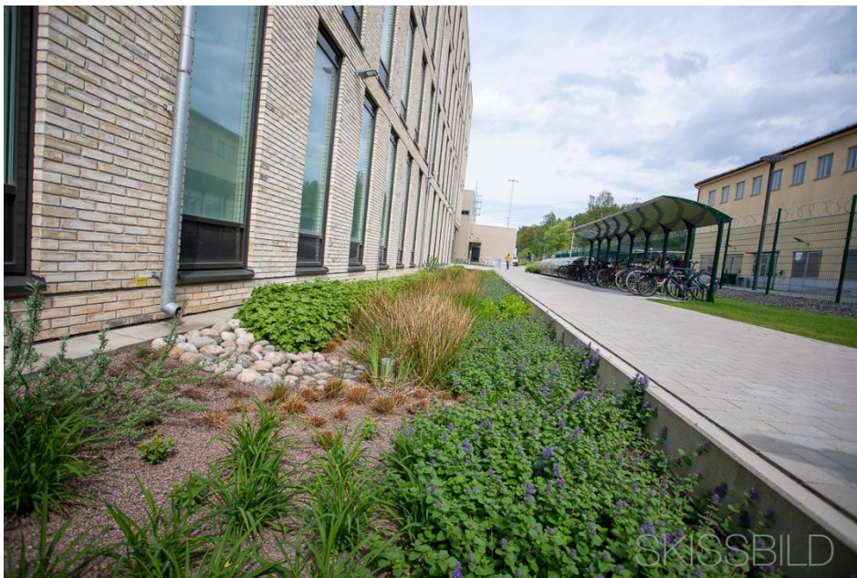
Figur 23 Nedsänkt regnrabatt utanför Kretslopp och vattens kontor som hanterar dagvatten från taktytor och mark. Foto: SKISSBILD
